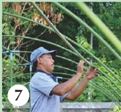
7 Pemasangan penguat konstruksi
